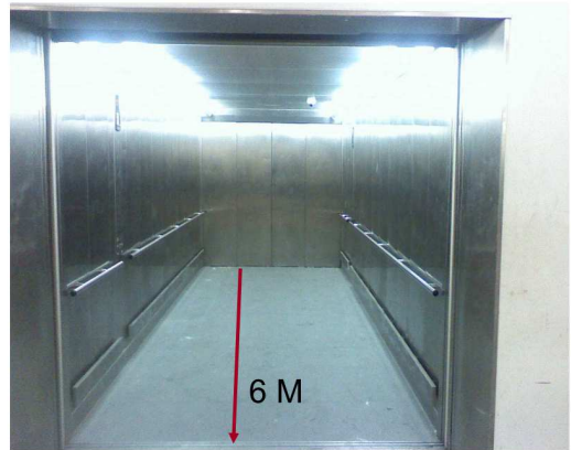
Door size 2.3 m. x 2.3 m. ขนาดประตู 2.3 เมตร x 2.3 เมตร Weight 2.5 tons สามารถบรรทุกได้ 2.5 ตัน Maximum weight per square meter = 500 kas.
